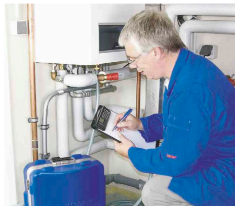
Befüllung mit richtigem Heizungswasser
